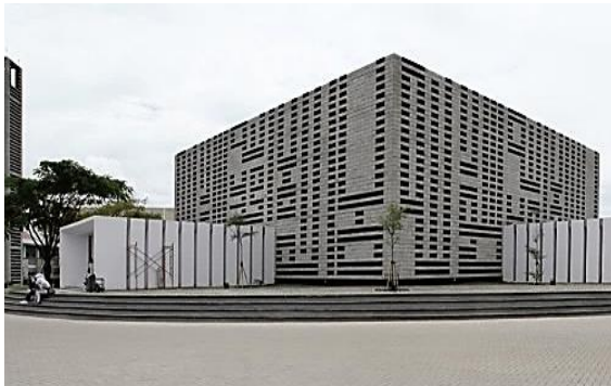
شكل يوضح المداخل الرئيسية للمسجد من ضلعي المسجد وتكون مسقوفة بهيكل كونكريتي يتكون من وحدات مكررة مطلية باللون الابيض
