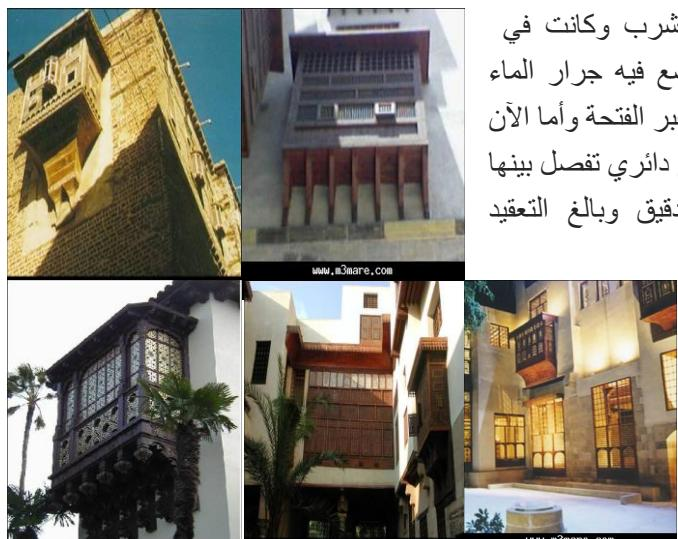
عبارة عن كلمة مشتقة من اللفظ العربي شرب وكانت في الماضي عبارة عن حيز بارز ذو فتحة منخلية توضع فيه جرار الماء الصغيرة لتبرد بفعل التبخر الناتج عن تحرك الهواء عبر الفتحة وأما الآن فهي عبارة عن فتحات منخلية شبكيّة خشبيّة ذات مقطع دائري تفصل بينها مسافات محددة ومنتظمة بشكل هندسي زخرفي دقيق وبالغ التعقيد
